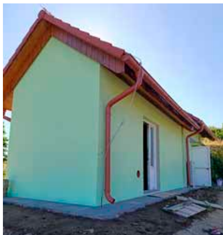
Budova úpravy vody
