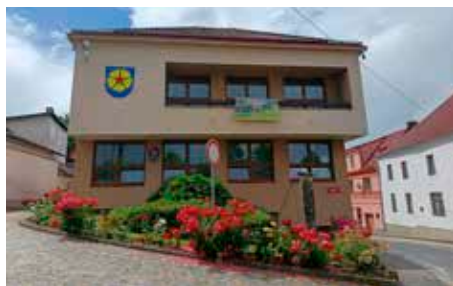
Budova městského úřadu
